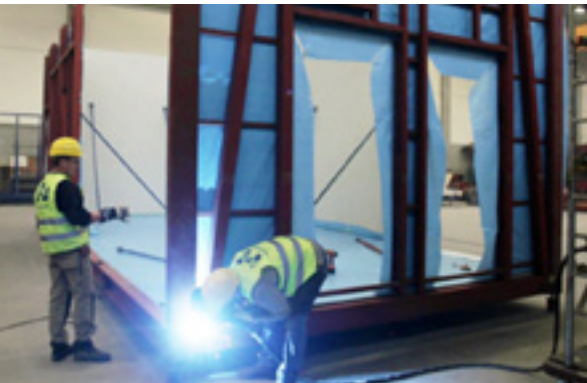
Konstruktion des äußeren Rahmens eines der 62 Module.
