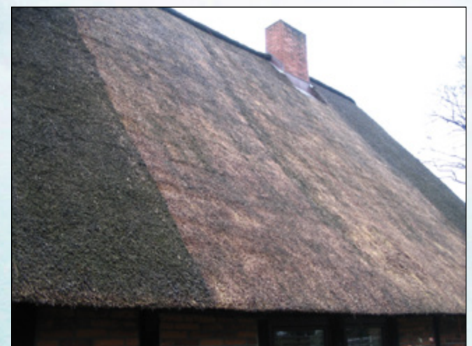
Abb. 4 angegriffenes Reetdach teilweise geschält und mit bioDECONT®-Reet behandelt
